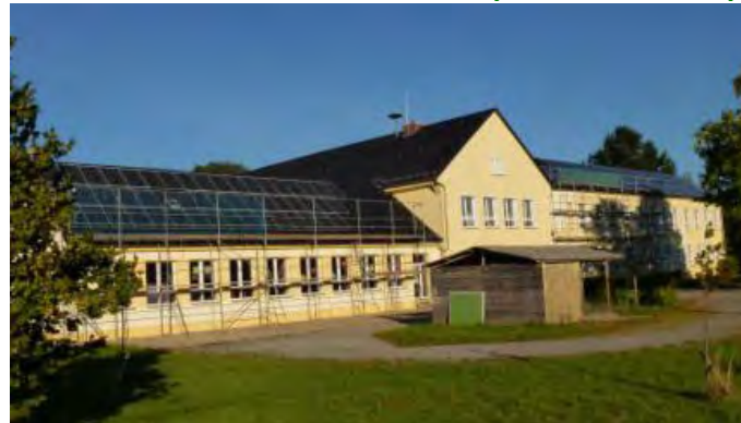
„Förderzentrum Hainspitz“ 39kWp
