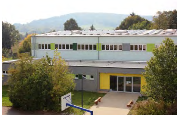
„Regelschule Heimbürge Kahla“ 73 kWp
